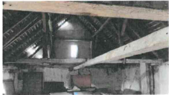
Interiér stavby - nadzemní podlaží
