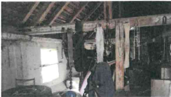
Interiér stavby - nadzemní podlaží
