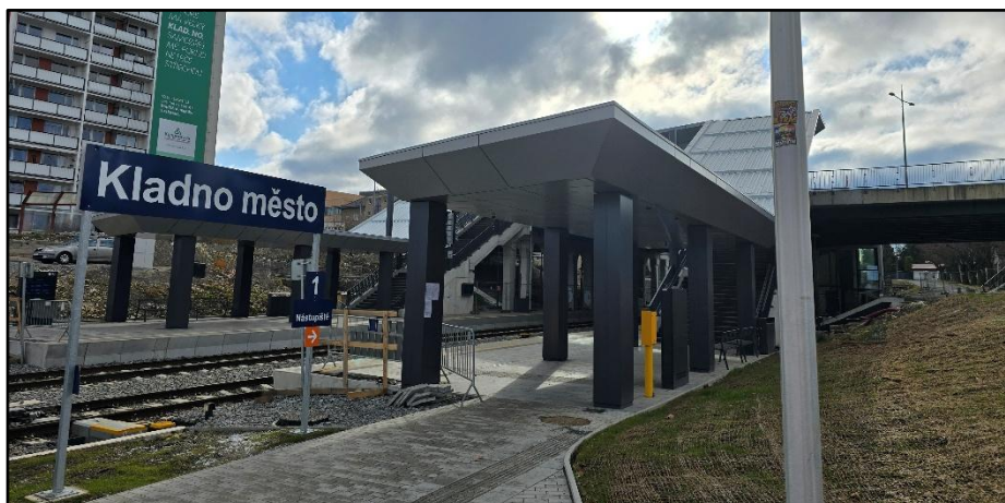
Projekt „Modernizace trati Kladno - Kladno Ostrovec“, foto: Auditní orgán
