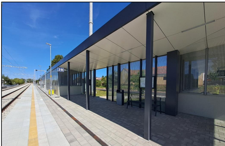
Projekt „Rekonstrukce traťového úseku Vlkov u Tišnova (mimo) - Křižanov (mimo)“, foto: Auditní orgán
