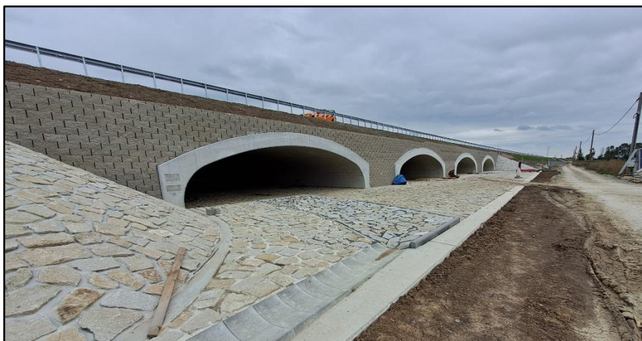
Inundační most v rámci projektu „Dálnice D1, stavba 0136, Říkovice – Přerov“, foto: Auditní orgán
