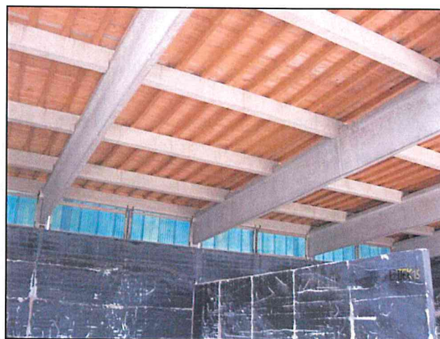
zastřešení po opravě
