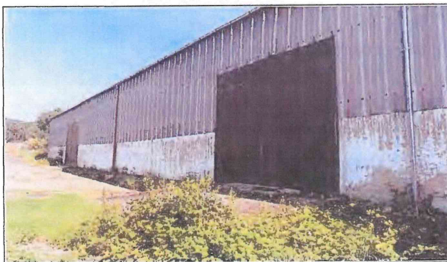
Obrázek 5: Ocelokolna od jihovýchodu
