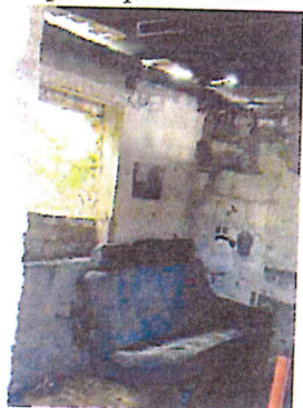
stavba bez čp/eč na pozemku st.p.č.98
