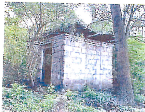
stavba bez čp/eč na pozemku st.p.č.98
