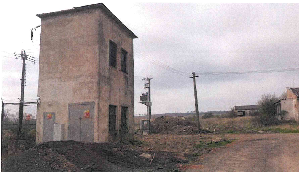
parc. č. 1496 (22 m 2 ) – zastavěná plocha a nádvoří
