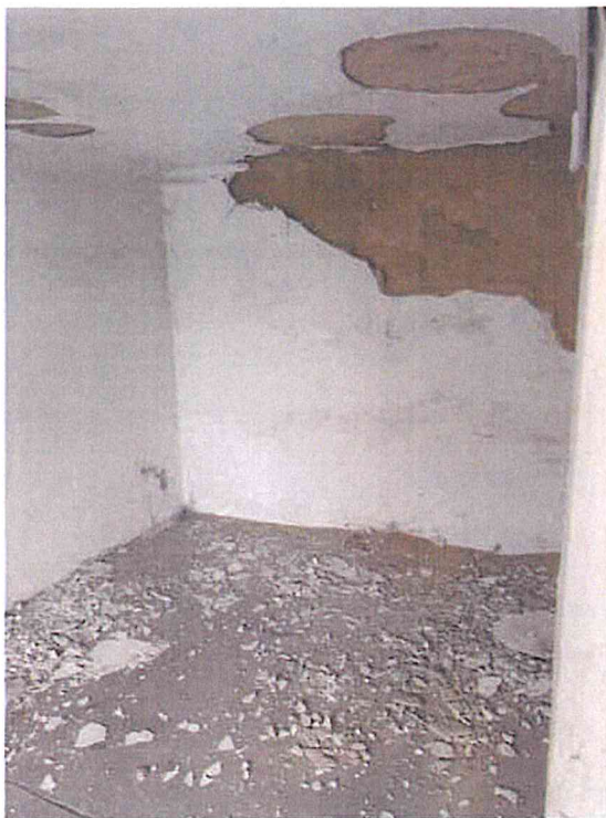
Objekt bez čp/če na pozemku parc.č. st. 102
