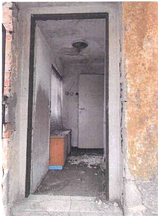
Objekt bez čp/če na pozemku parc.č. st. 102
