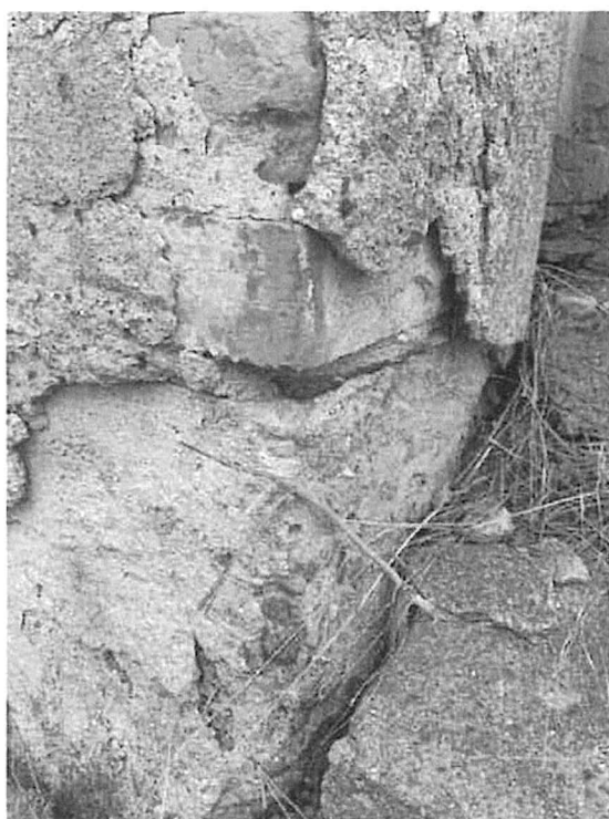
Objekt bez čp/če na pozemku parc.č. st. 102
