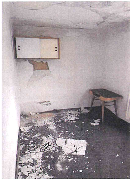
Objekt bez čp/če na pozemku parc.č. st. 102
