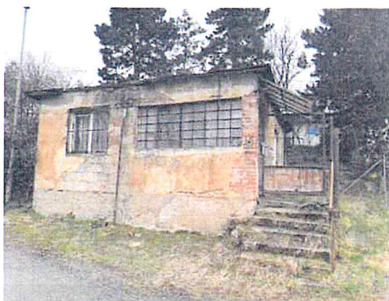
Objekt bez čp/če na pozemku parc.č. st. 102
