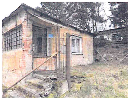
Objekt bez čp/če na pozemku parc.č. st. 102
