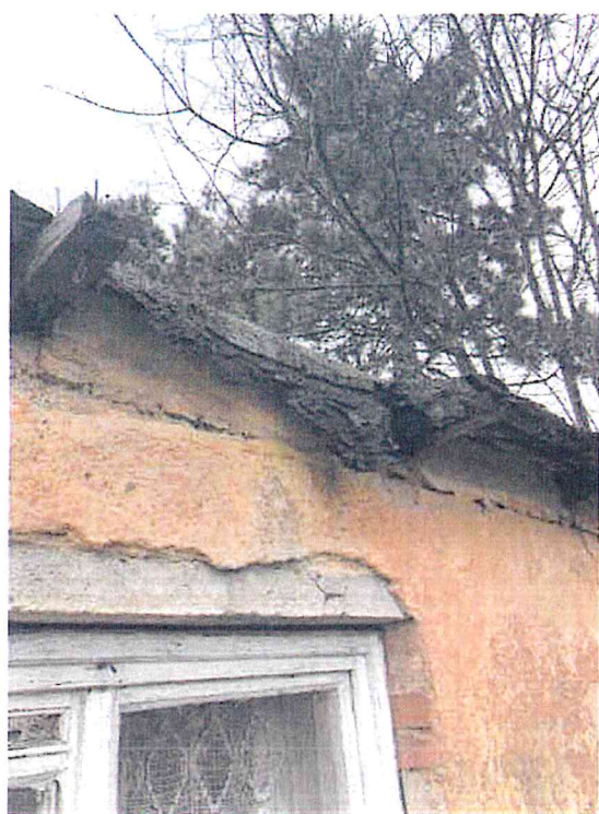
Objekt bez čp/če na pozemku parc.č. st. 102
