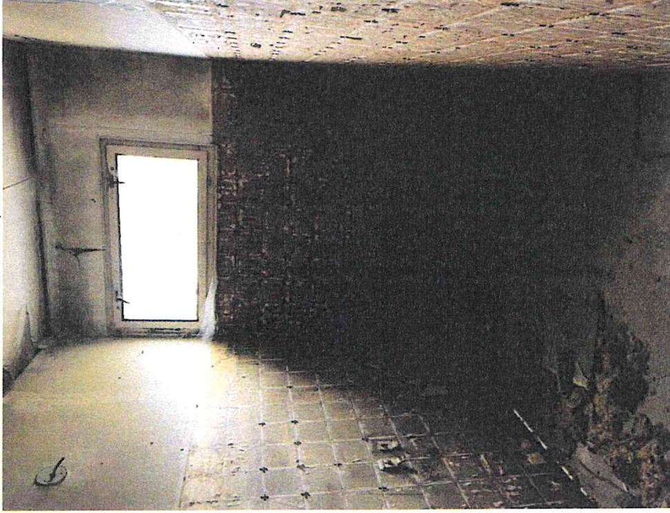
Pohled na interiér rodinného domu č. p. 48
