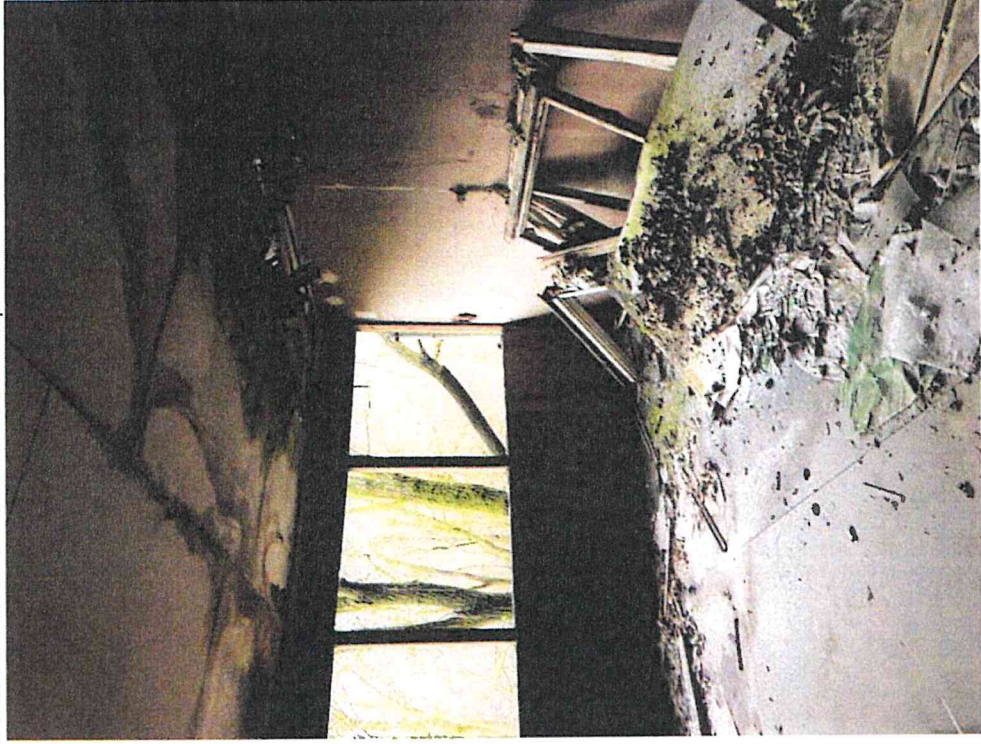
Pohled na interiér rodinného domu č. p. 47
