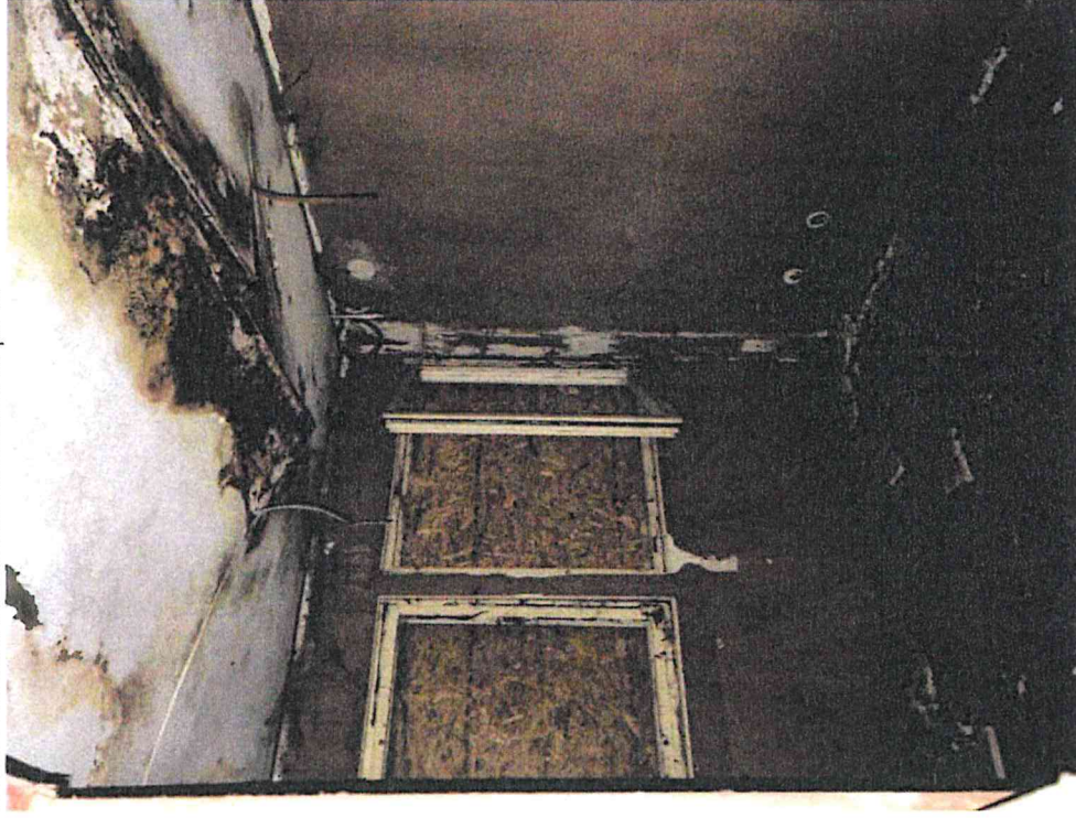
Pohled na interiér rodinného domu č. p. 48
