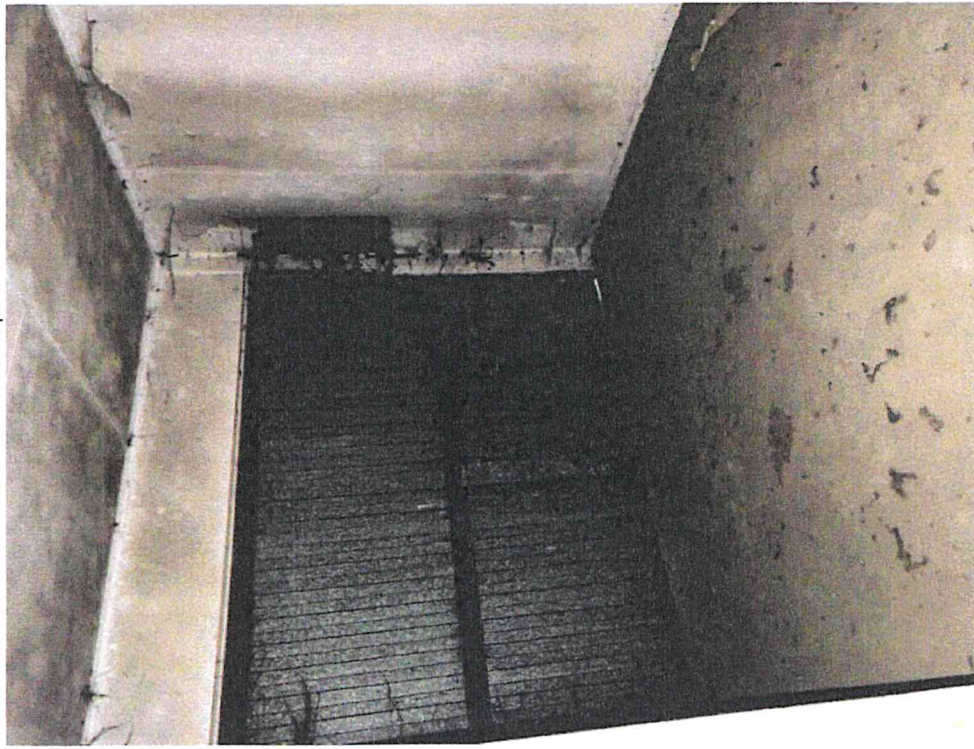
Pohled na interiér rodinného domu č. p. 50
