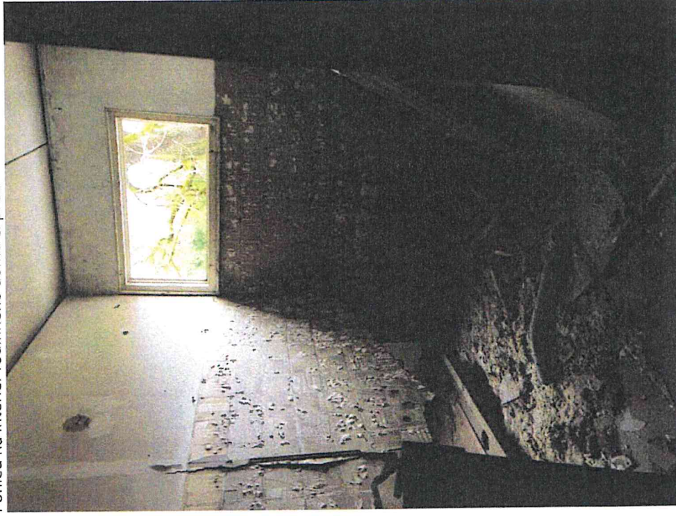
Pohled na interiér rodinného domu č. p. 50
