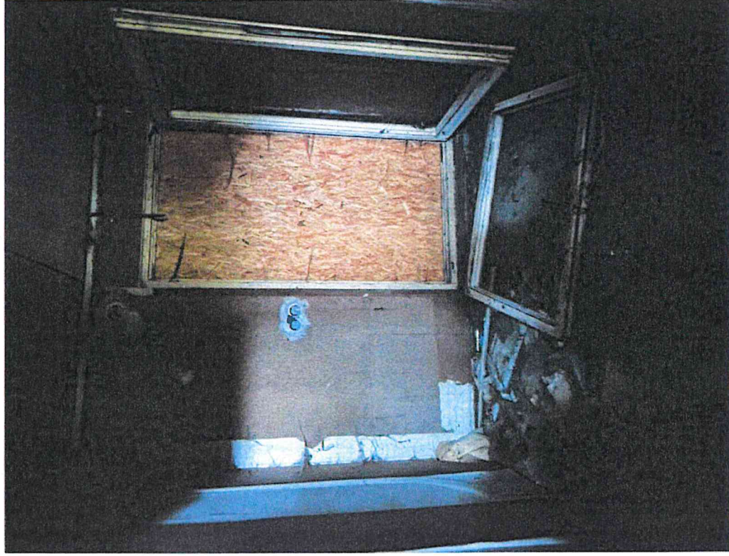
Pohled na interiér rodinného domu č. p. 41
