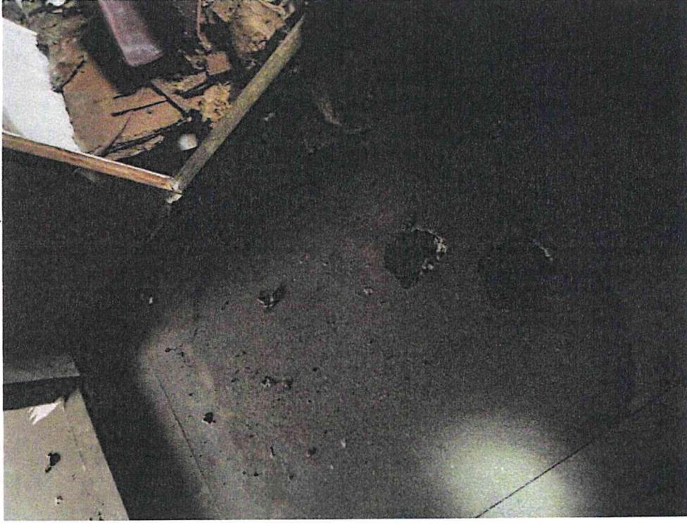
Pohled na interiér rodinného domu č. p. 48
