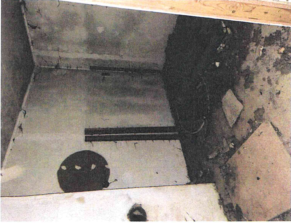
Pohled na interiér rodinného domu č. p. 47
