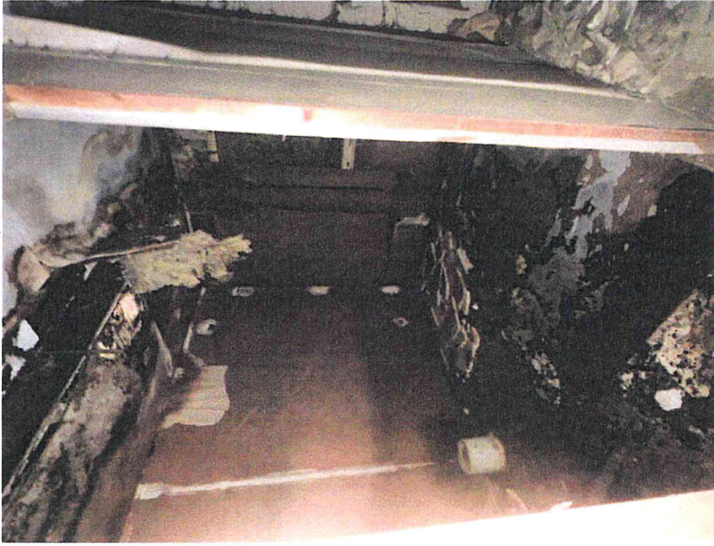
Pohled na interiér rodinného domu č. p. 41
