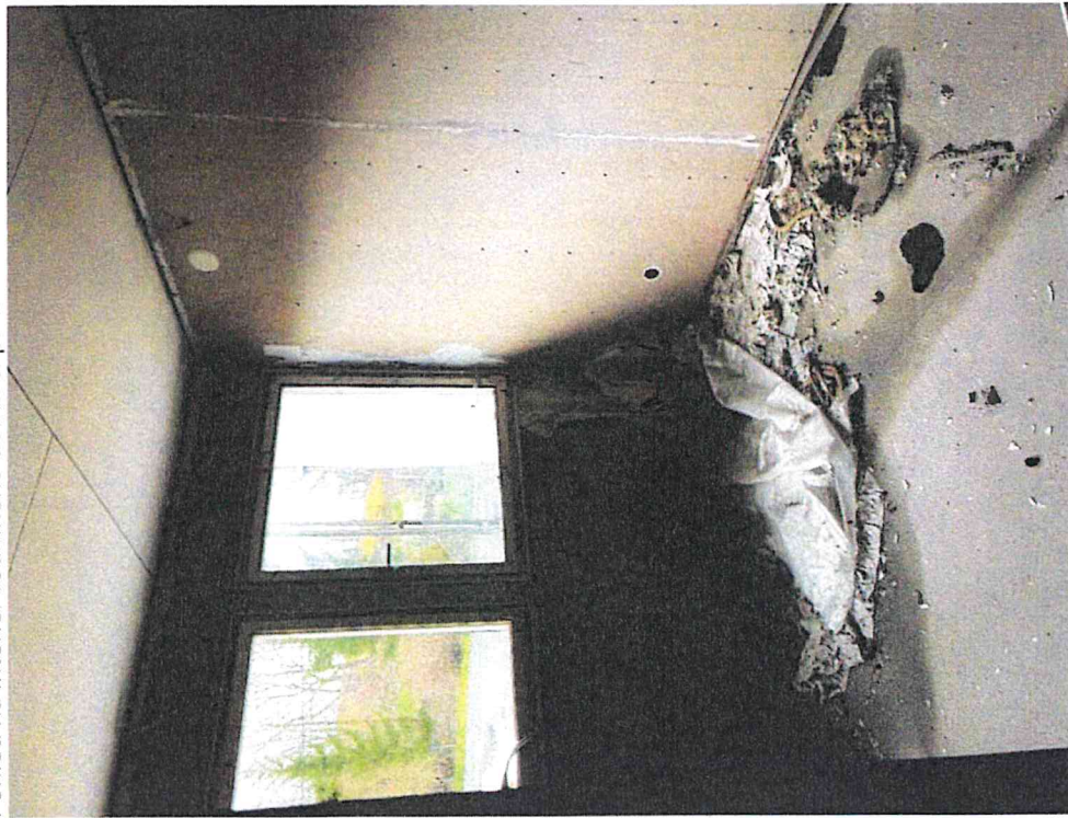
Pohled na interiér rodinného domu č. p. 47
