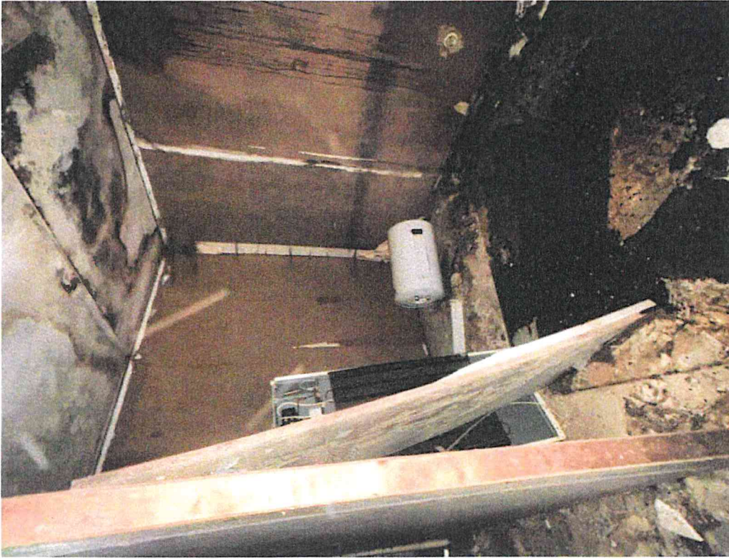
Pohled na interiér rodinného domu č. p. 41
