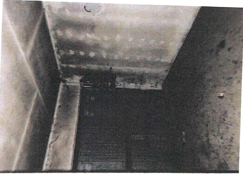
Pohled na interiér rodinného domu č. p. 47
