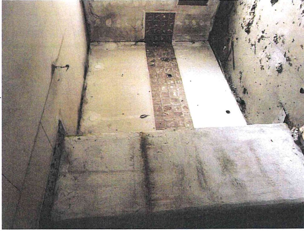
Pohled na interiér rodinného domu č. p. 47
