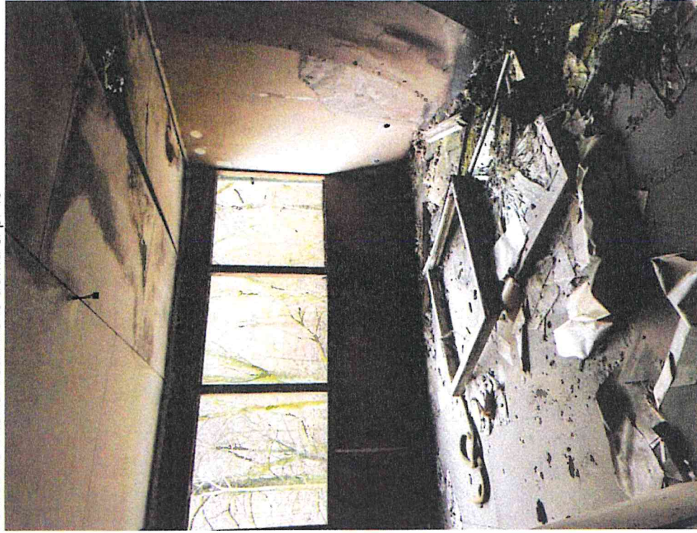
Pohled na interiér rodinného domu č. p. 49
