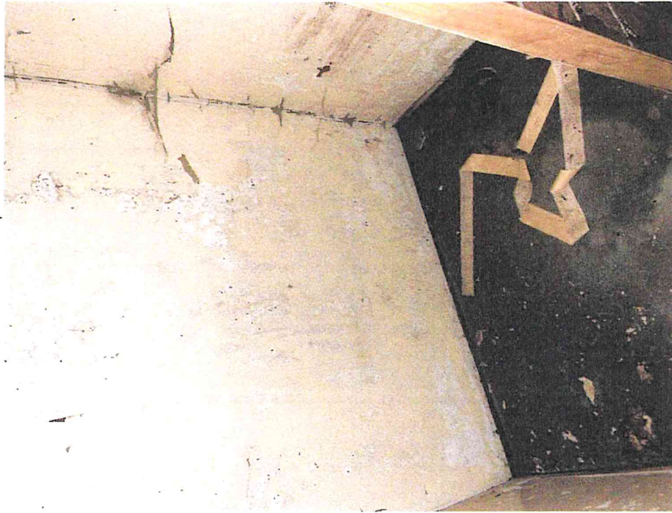
Pohled na interiér rodinného domu č. p. 43
