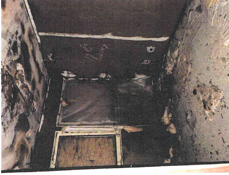
Pohled na interiér rodinného domu č. p. 50
