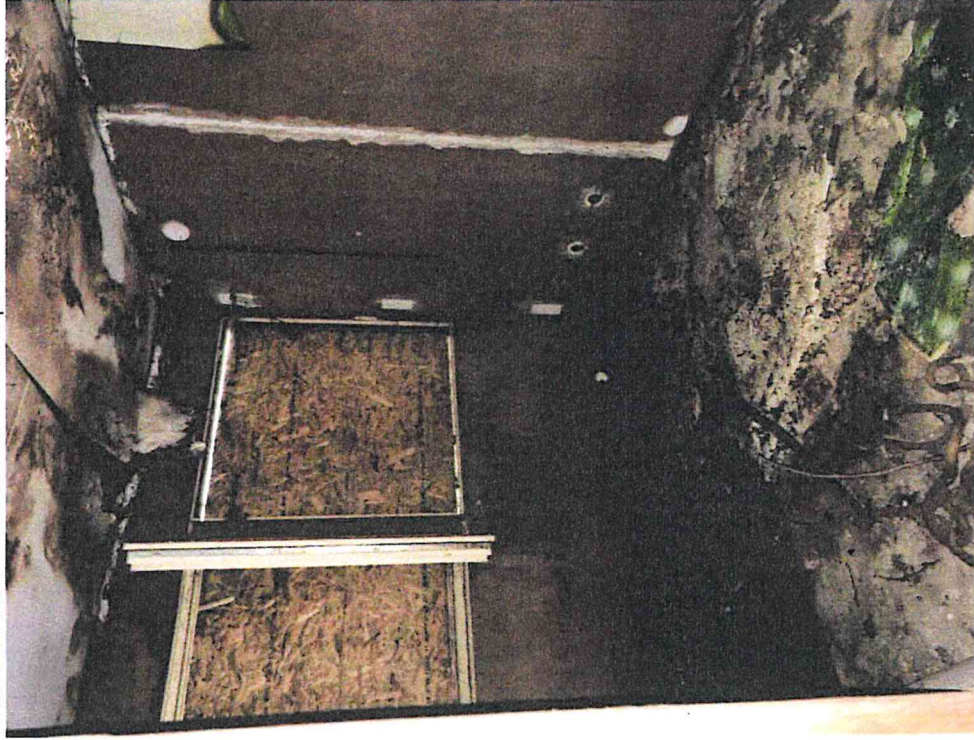
Pohled na interiér rodinného domu č. p. 47
