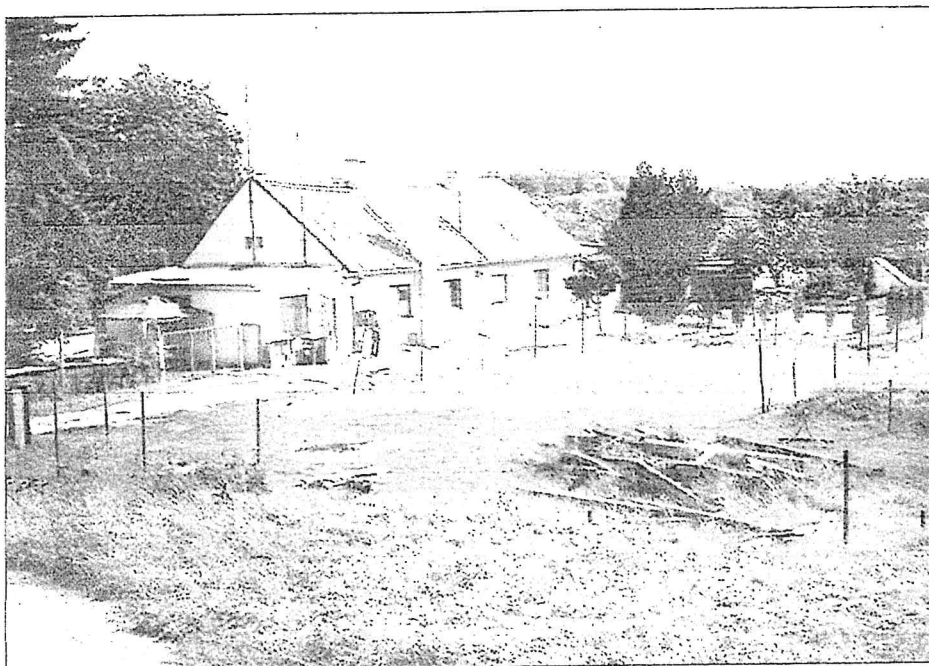
Obr. č. 2 - Celkový pohled – rodinné domy
