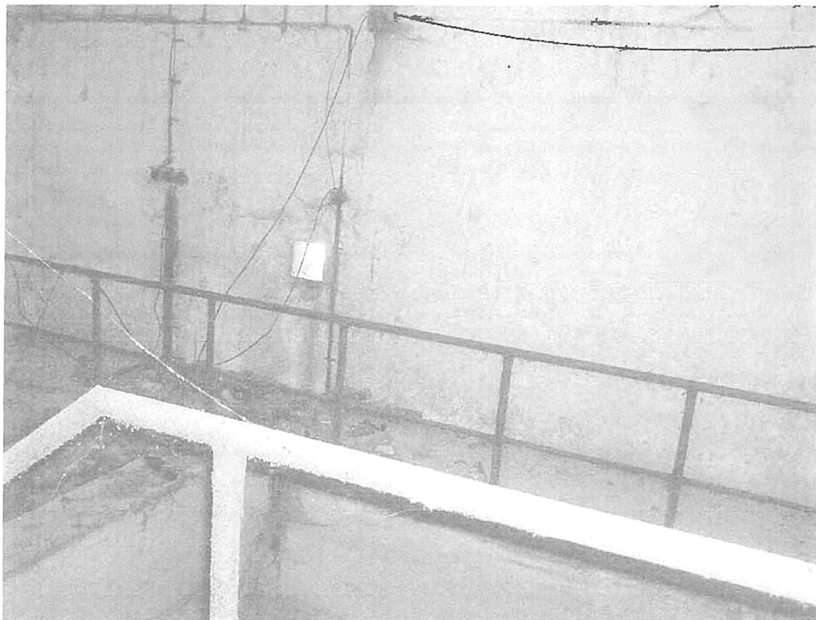
Pohled venkovní vnitřní 2
