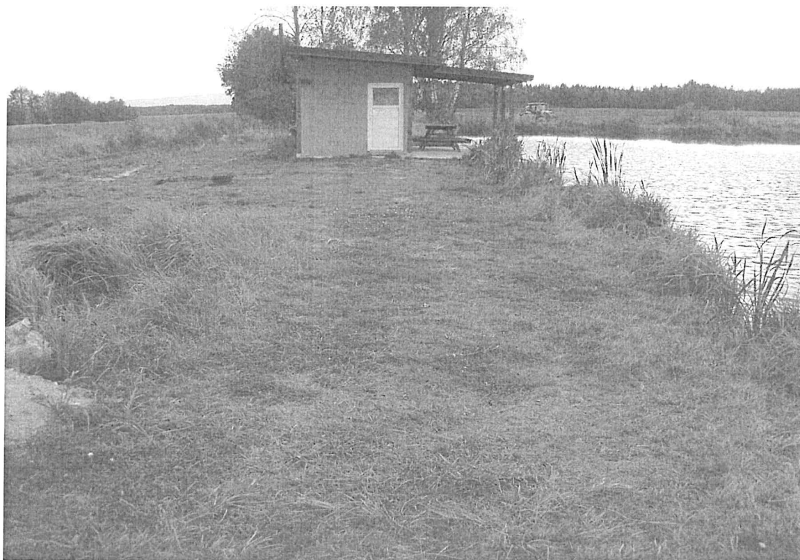
Obr. 4 Pohled na jižní část p.p.č. 638 - hráz, k.ú. Nová Ves u Křižovatky
