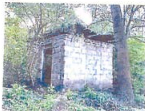
stavba bez čp/eč na pozemku st.p.č.98
