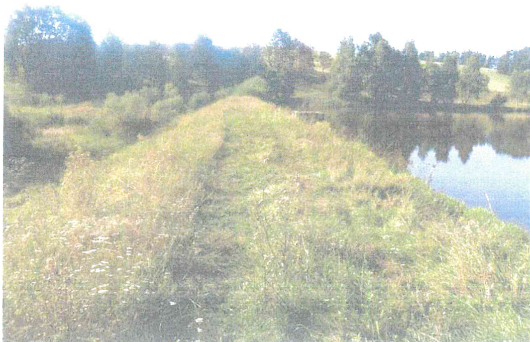
Pohled na výpustní objekt
