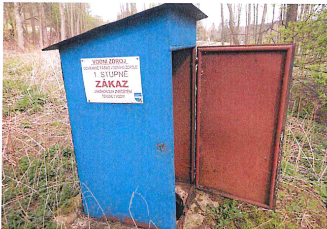
Původní vodojem na parc. č. 866/3
