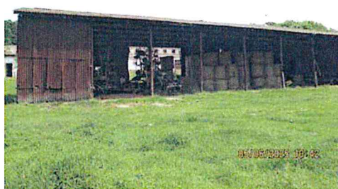
Pohled jihozápadní levá část
