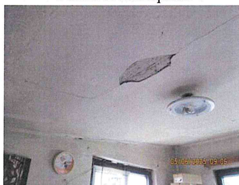
Zatékání střechou
