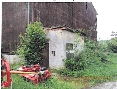
Přístavba bývalé strojovny
