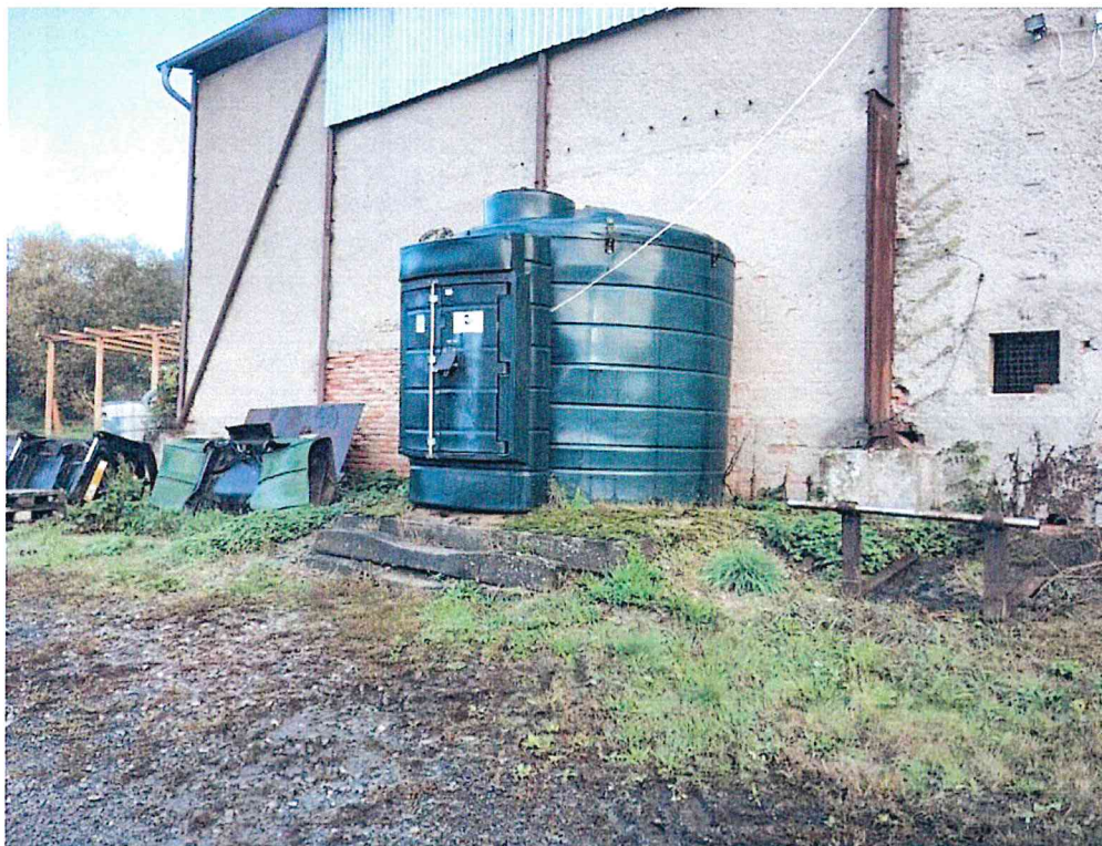
Obrázek č. 5. - Nádrž na naftu vedle ocelokolny
