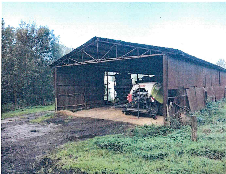
Obrázek č. 8. - Budova ocelokolny
