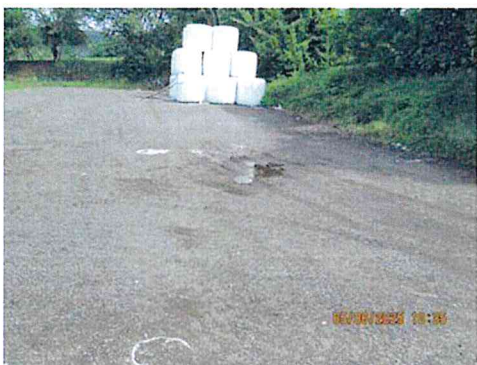
Zpevněná plocha před hnojným platem a silážním žlabem
