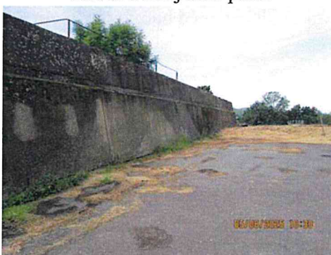
Pohled na silážní žlab severovýchodní
