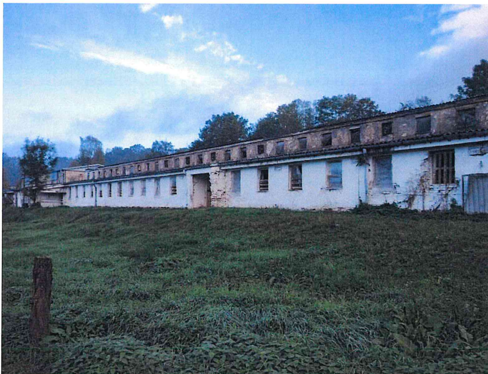
Obrázek č. 6. - Budova kravína
