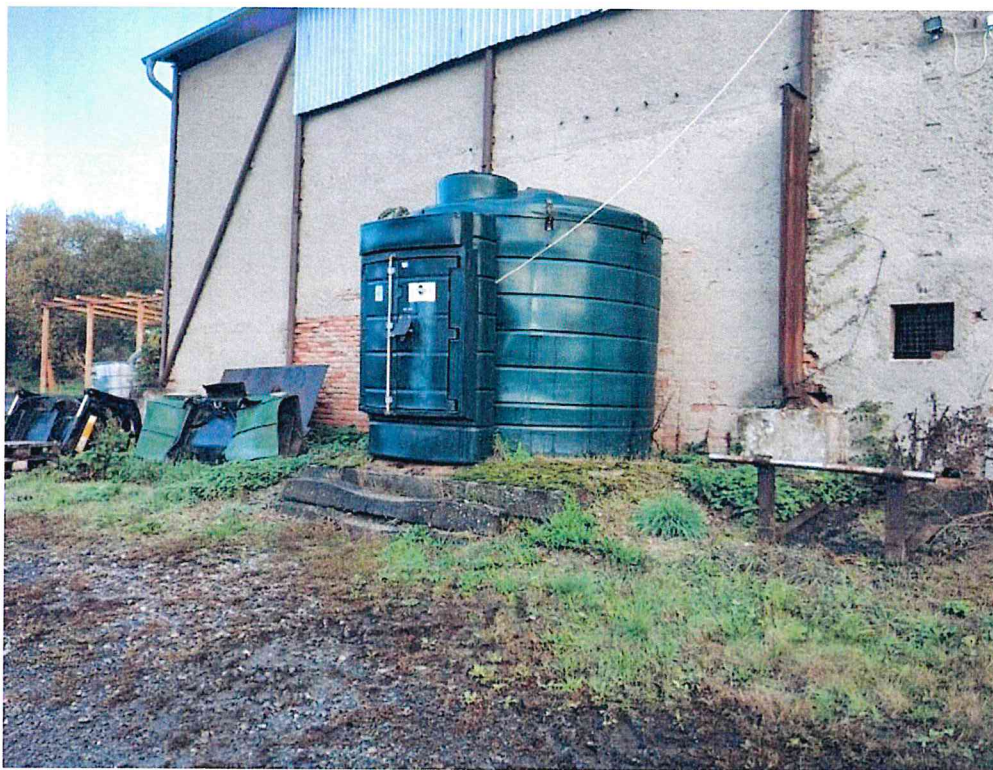
Obrázek č. 5. - Nádrž na naftu vedle ocelokolny
