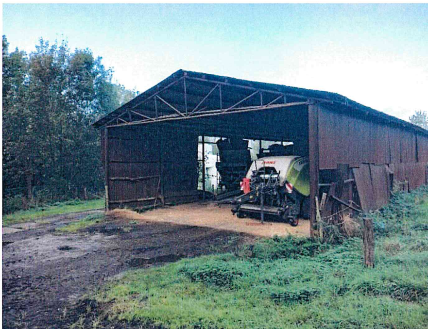
Obrázek č. 8. - Budova ocelokolny
