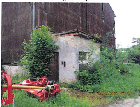
Přístavba bývalé strojovny
