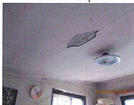
Zatékání střechou
